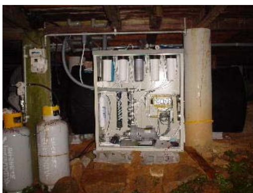
■設置例(バンガローの床下へ設置した川水浄水 Ro 飲料装置 1.5 トン/日) 和歌山県 善田 M 氏邸
